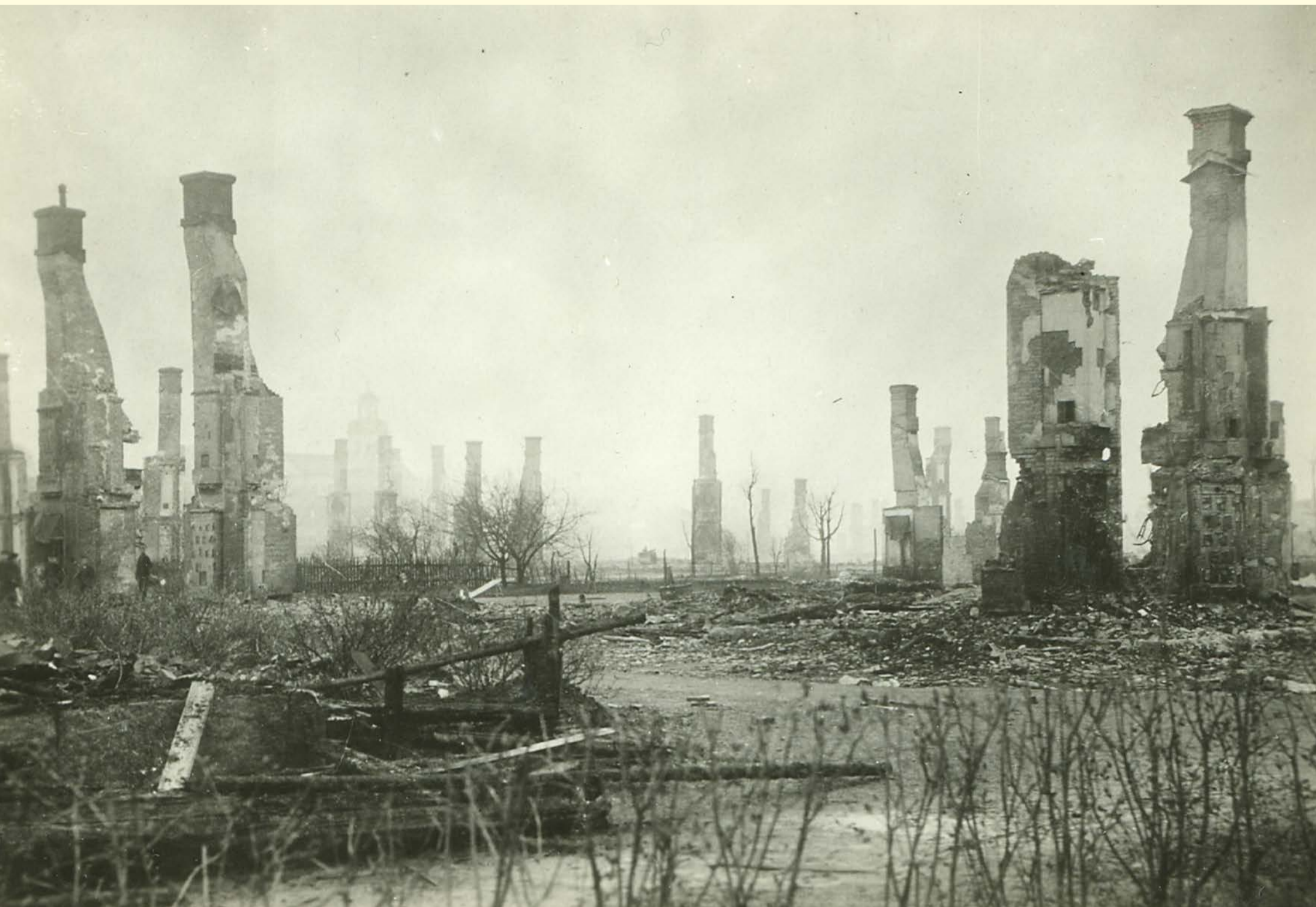
Åmåls nedbrunna hus.
