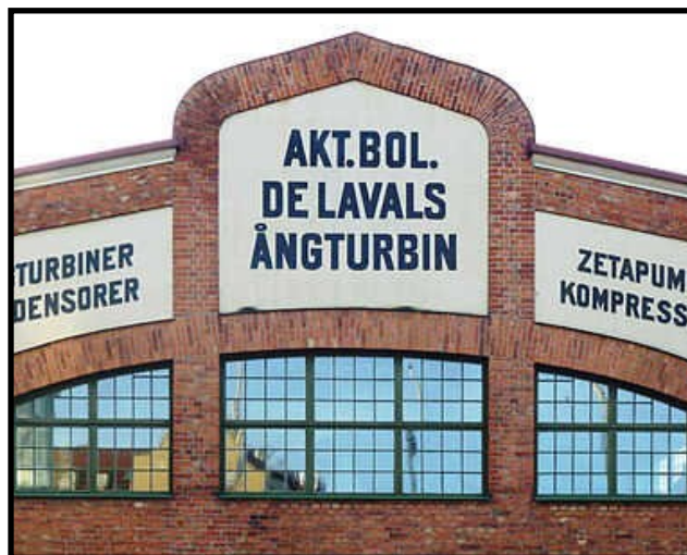
AB De Laval's Ångturbin i Nacka, företaget levererade nytt kraftaggregat till Skara Elverk 1927
