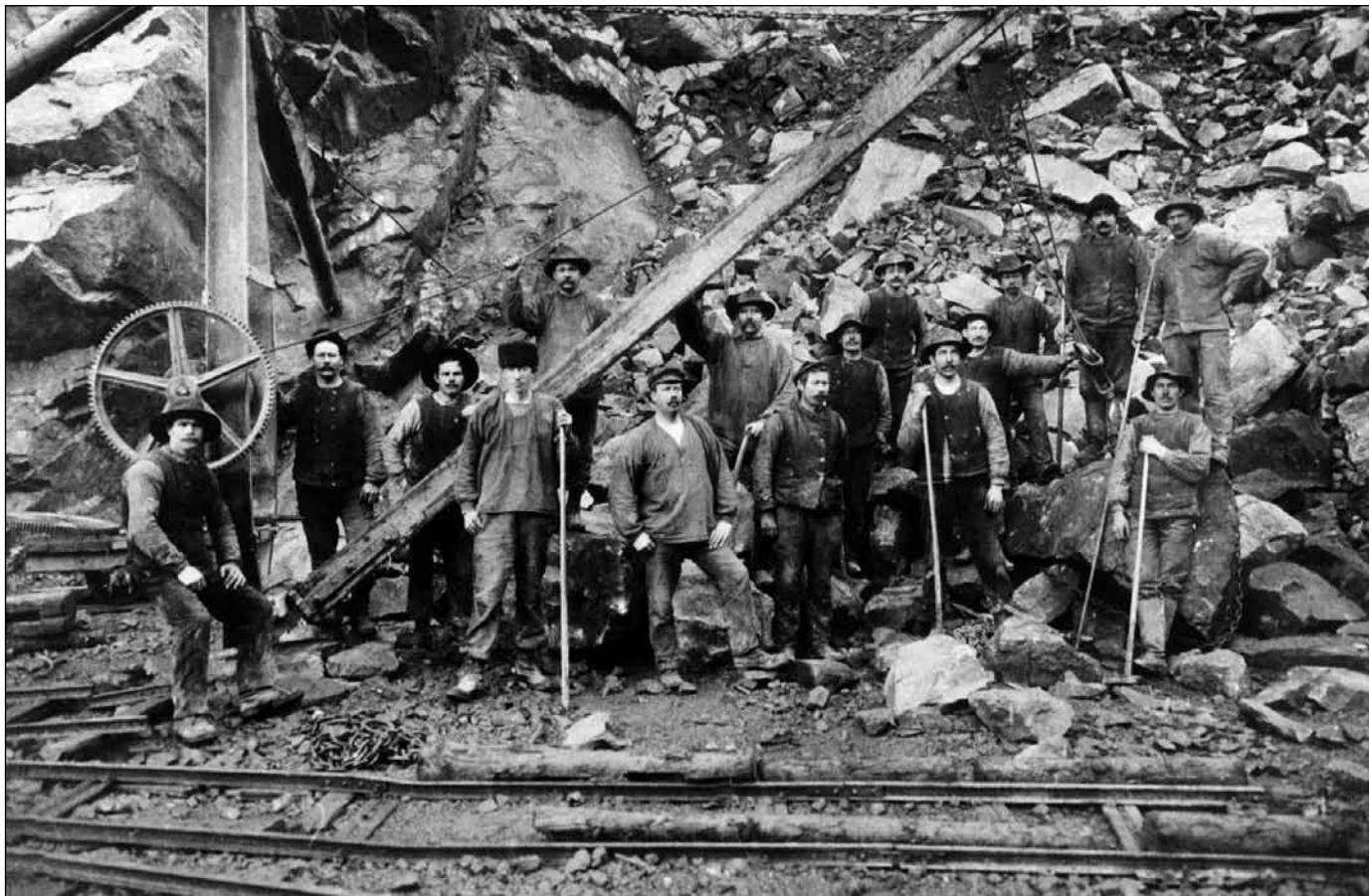
Vattenrallare vid bygget av Olidans kraftstation i Trollhättan 1915. Fotografen är okänd
