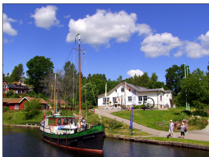
Kanalmuseet finns sedan 50 år i det gamla kontoret för Håfreströms bruk, alldeles intill kanalen
